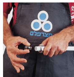
3 Вставка соединителя в трубу
